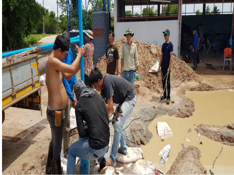
รูปที่ ๑๒ แสดง งานติดตั้งปั๊มน้ำ
