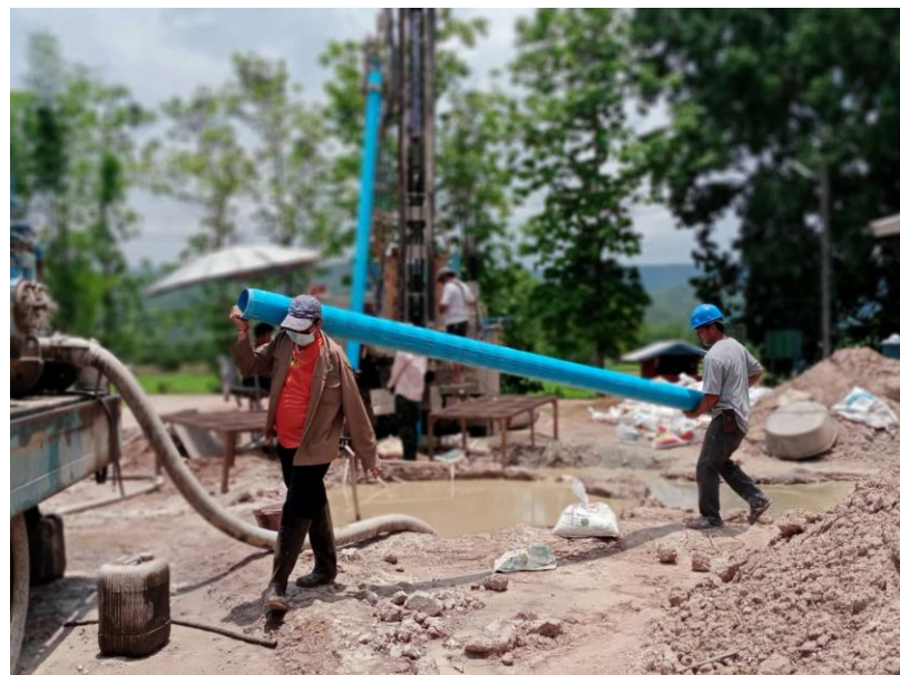
รูปที่ ๙ แสดง งานการลงท่อท่อกรู ท่อเจาะร่อง
