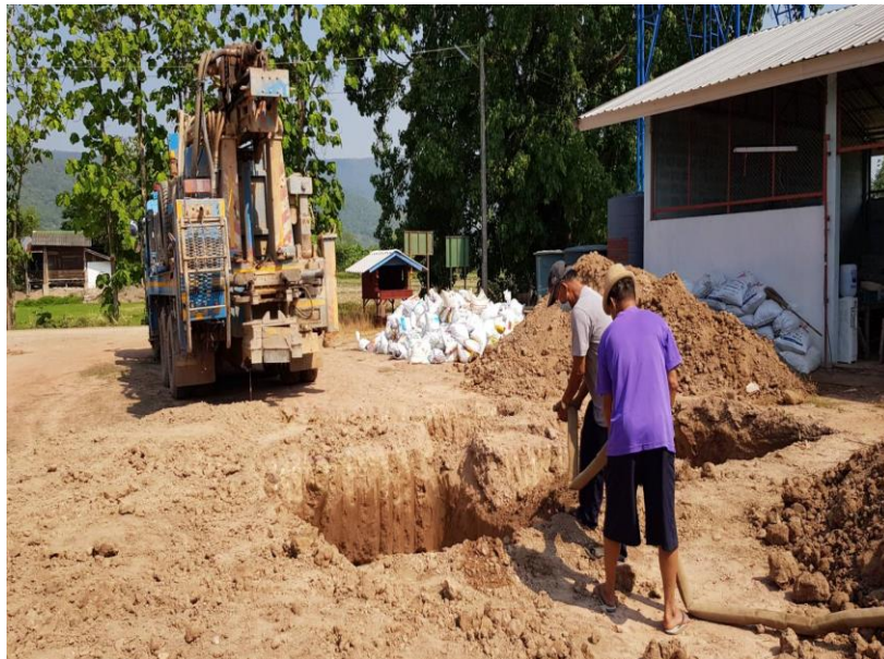
รูปที่ ๕ แสดง หลุมบ่อน้ำโคลน จำนวน ๒ บ่อ กว้าง ประมาณ ๒ เมตร ยาว ๒ เมตร ลึก ๑.๕ เมตร
