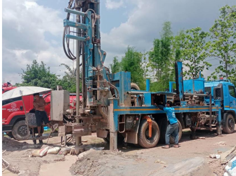
รูปที่ ๘ แสดง งานขุดเจาะคว้าน
