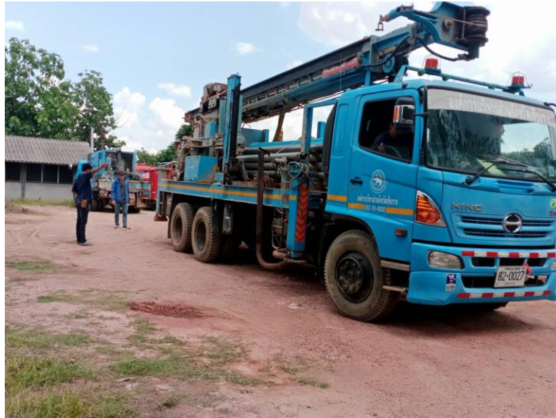
รูปที่ ๔ แสดง ขนย้ายเครื่องจักรกลชุดขุดเจาะบ่อน้ำบาดาล เข้าพื้นที่บ้านโรงช้างใต้ ม.๔ ตำบลโรงช้าง อำเภอบ้านดง จังหวัดบุรีรัมย์
